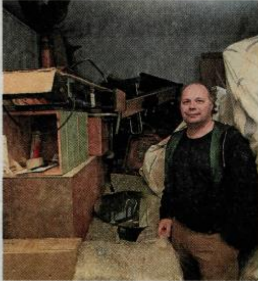
Ersatzplatz. Markus Plaens Wohnung ist durch Bauschäden kaum nutzbar.
